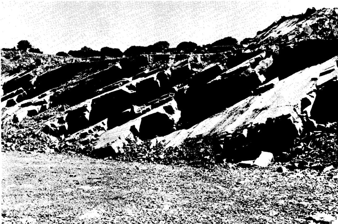
Foto 6. *Aspecto de un talud excavado con perforación y voladura.*
